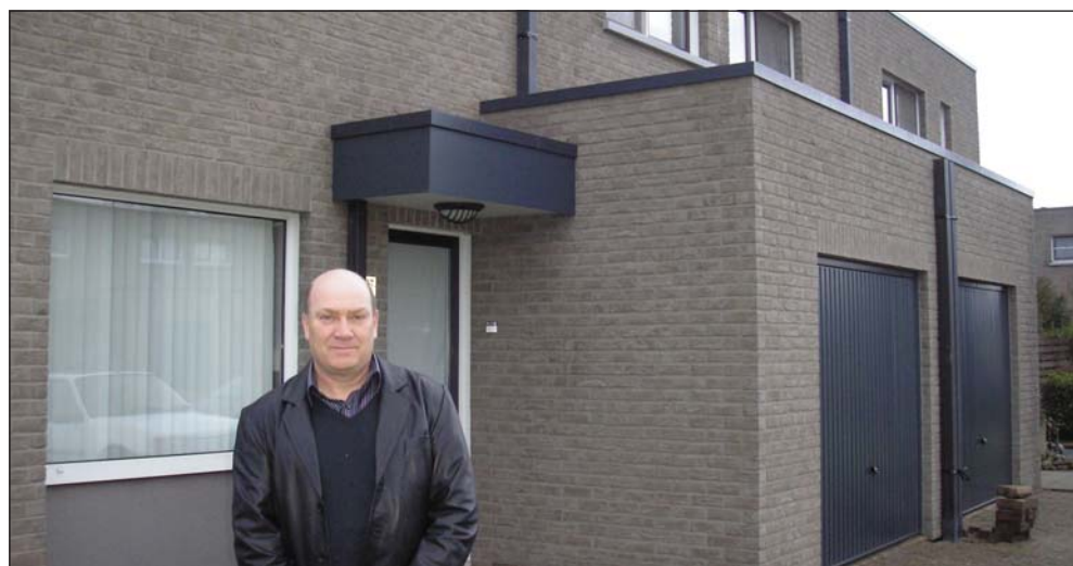
Mathieu Smeets, ondervoorzitter van Ons Dak, vóór één van de gerenoveerde gevels
